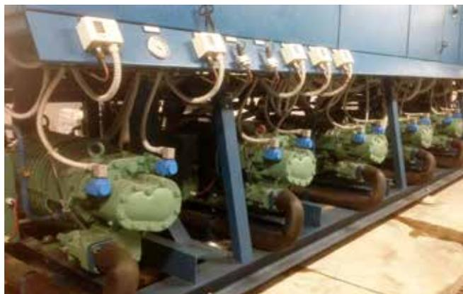
**FIGURA 1 - Centrale MT del sistema ibrido R-404A/CO<sub>2</sub> di Seregno, convertita a Opteon XP40 nell'ambito di un progetto pilota**
