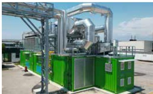
e consente di produrre 2.700 kW di energia elettrica a diretto utilizzo per lo stabilimento e circa 500 kW di energia termica per il reparto bitumi, oltre a generare fino a 1500 kW di acqua fredda per il reparto sintetici, consentendo di fermare gli attuali frigoriferi elettrici presenti nello stabilimento. L'intero impianto permette un risparmio di emissioni di gas serra prodotto di 2.100 ton di CO<sub>2</sub>/anno.
