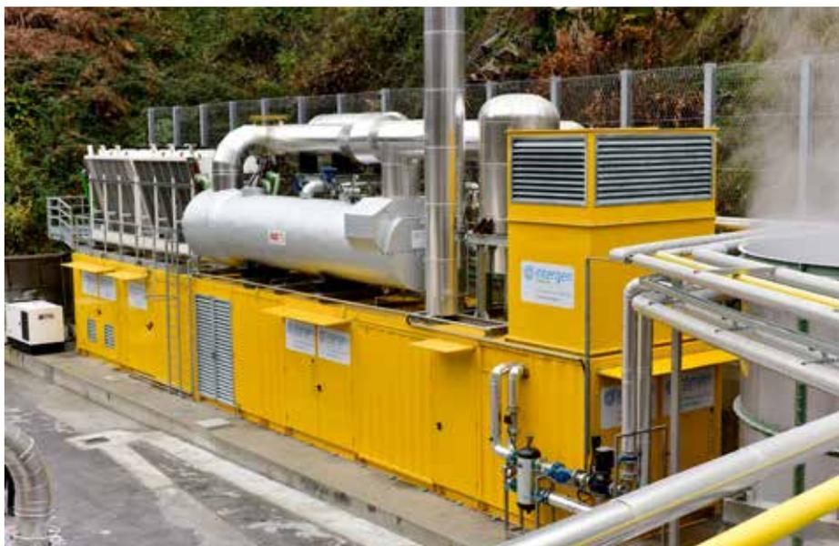
1200 Kg/h a 18 bar, utilizzato per la dispendiosa fase di essiccazione della carta. Dalle camicie dei cilindri e dal circuito di raffreddamento dell'olio sono invece recuperati circa 1.050 kWt, che alimentano un anello di distribuzione di acqua calda con un salto termico di 70-86°C. Il sistema di recupero termico relativo all'impiego dell'acqua calda è stato inoltre ottimizzato, sviluppando utilizzi termici in diversi punti di stabilimento.
